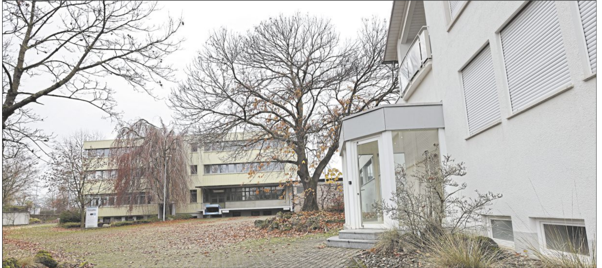
Das frühere Firmengelände von Eisele Pneumatics in Waiblingen wird zu einem Campus für Arbeit und Bildung.
